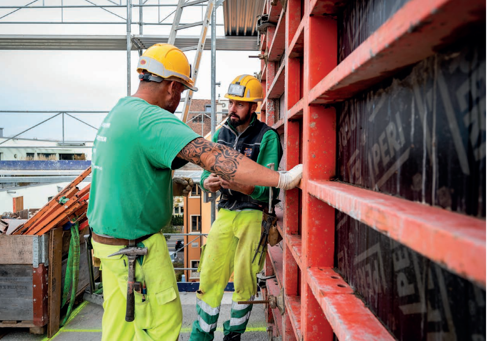
Das Team der Bereuter Bau AG schalt die Betonwände im obersten Geschoss des östlichen Letzigraben-Mehrfamilienhauses.
