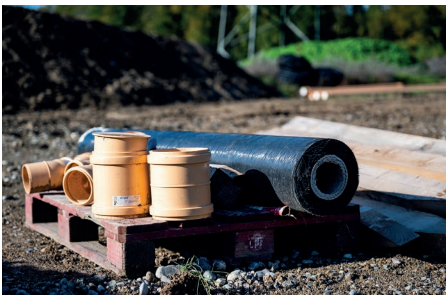
Material, um das Drainagenetz mit Sickerleitungen zu ergänzen.
