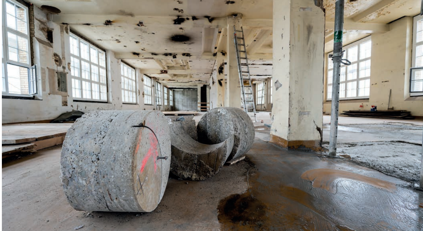
Für Beton-Schneid- und -Bohrarbeiten spannt das Baur-Team mit den Kollegen der Betonab AG zusammen.
